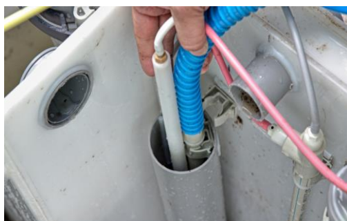
Enlèvement de la pompe air-lift (pompe à air), du filtre à grosses impuretés – voir fig. 1, no. 4 du guide (localisation du filtre à grosses impuretés dans la station)
